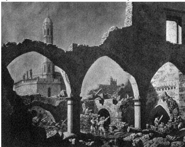
RUINAS DEL PATIO DEL HOSPITAL GENERAL DE N. S. DE GRACIA.
